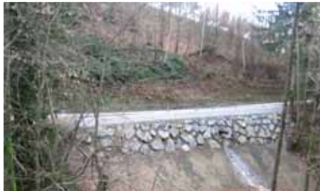
Verbindungsstraße Oberlatein (Rutschung), 30 x 7 m, 498 t Steine, € 45.000,-
