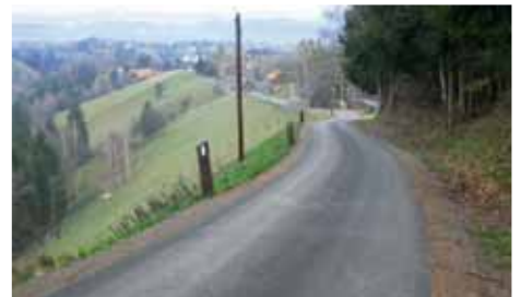
Neue Asphaltdecke und Verbreiterung: Walcher Erich, Richtung Oberhaag
