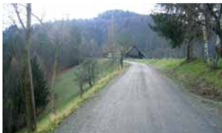
Neue Asphaltdecke: Sterzberg
