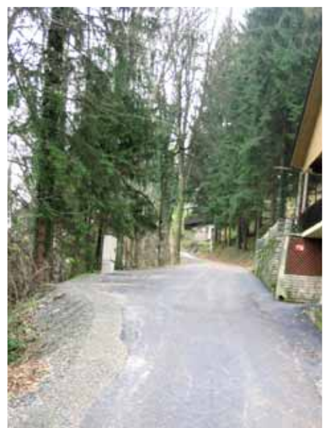
Neue Asphaltdecke, Auffahrt St. Pongratzen Wochenendhäuser
